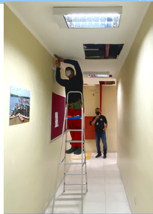
Intervenções na estrutura física preservam o patrimônio público e garante segurança às pessoas
